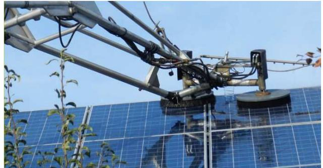
Die Firma Solarfresh bietet bereits seit einigen Jahren eine hochwertige maschinelle Reinigung mit einer Spezialmaschine an, die beim Europäischen Patentamt patentiert ist. Dabei können dank der stattlichen Auslage des 18 t schweren Manitou-Teleskopladers fast alle Hindernisse überwunden werden.
